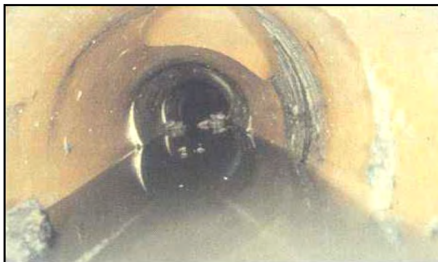
شکل ۶-۱۹- اتصال فاضلابروی جانبی در موقعیت ساعت ۱
