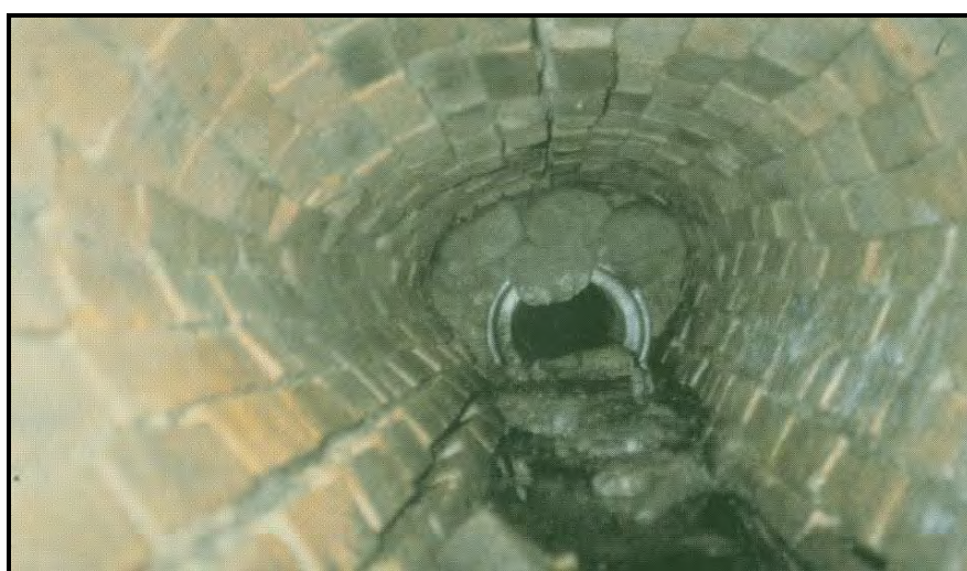
شکل ۶-۲۳- تغییر در شکل فاضلابرو به مقطع دایروی
