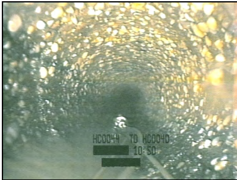
شکل ۶-۱۰-د- آسیب سطحی، بیرون زدگی سنگدانه‌ها از ساعت ۷ تا ساعت ۵
