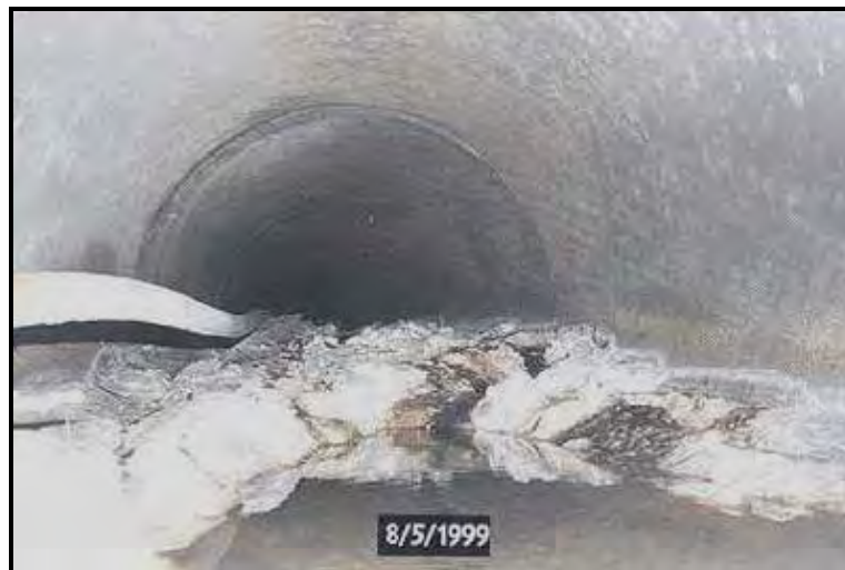
شکل ۶-۱۷-د- مانع در مسیر از نوع لوله یا کابل خارجی در ساعت ۹
