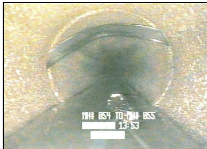
شکل ۶-۲۱- ورود واشر آب‌بند به فضای داخل لوله (SR)، از ساعت ۹ تا ۲
