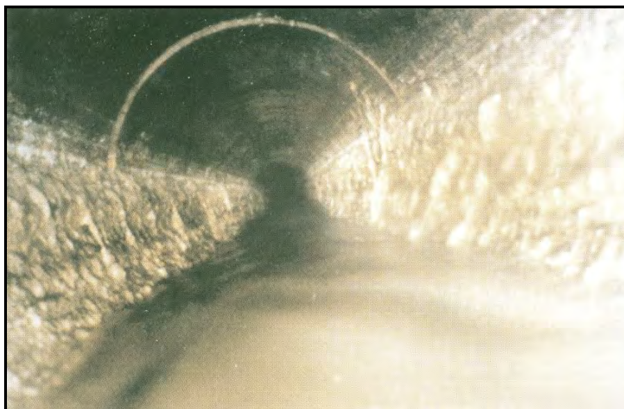
شکل ۶-۱۴-ج- رسوبات چسبیده از نوع گریسی از ساعت ۲ تا ساعت ۴ و از ساعت ۸ تا ساعت ۱۰
