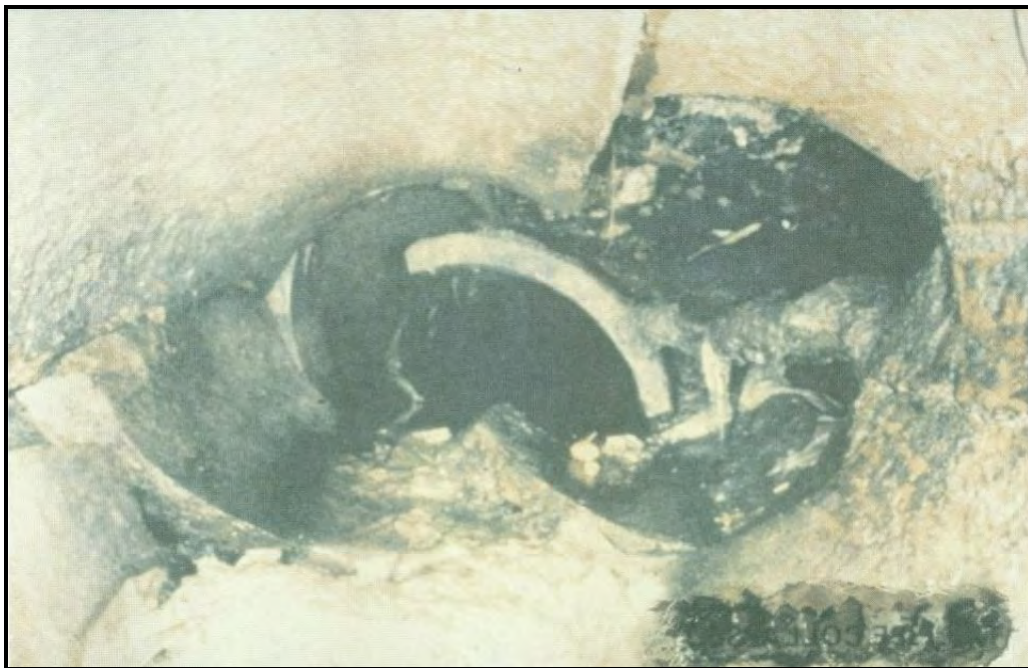
شکل ۶-۷- فروریزش در فاضلابرو با کاهش سطح مقطع به میزان ۵۰٪
